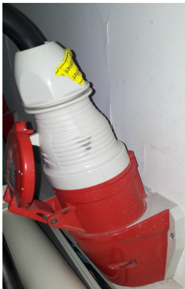
三相电源插头插接在插座上
