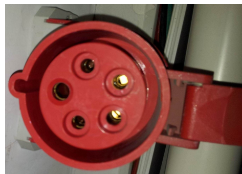
三相电源插座（防护盖打开）
